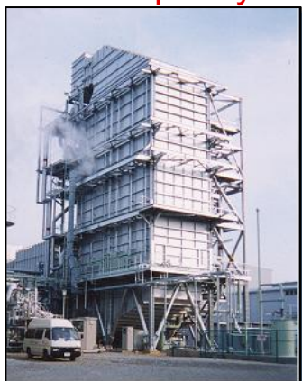
Vertical Type HRSG
