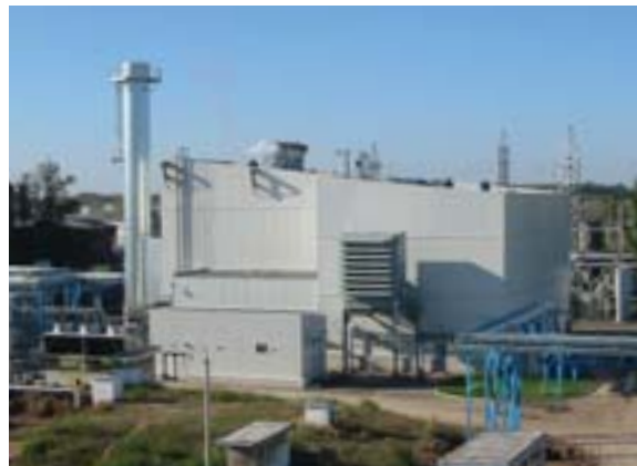
Uralsk cogeneration plant (Kazakhstan)
